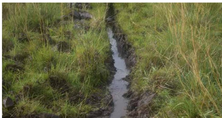
Foto 2. Canalización del terreno para drenar la humedad.
